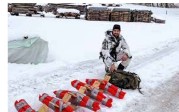
Vorbereitung der Sprengladungen durch T. Grassl
